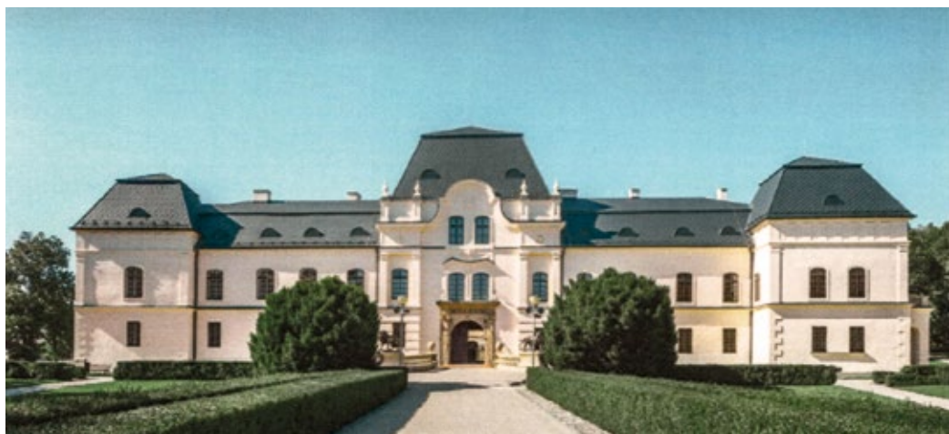
Zámek v Humenném, kde technickou podporu při rekonstrukci střechy zajišťovala firma Darvi & partners
