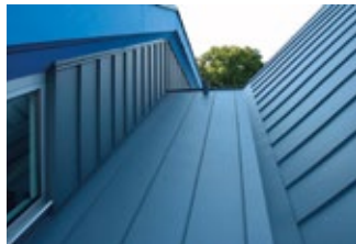
Ukázka precizní práce pana Mitaše na střeše moderního kostela
