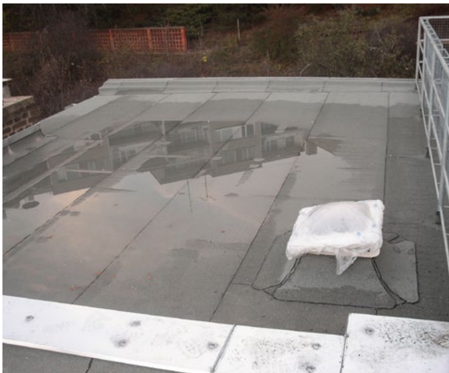
5) Pohled na chybně vyspádovanou střechu po její opravě včetně zateplení
