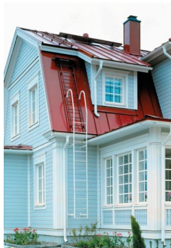
Bezpečnostní prvky Ruukki - lávky a žebříky zajišťují přístup pro údržbu komínů
