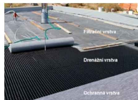
Obr. 2 Pokládka extenzivního vegetačního souvrství (zdroj Ekrost s.r.o.)
