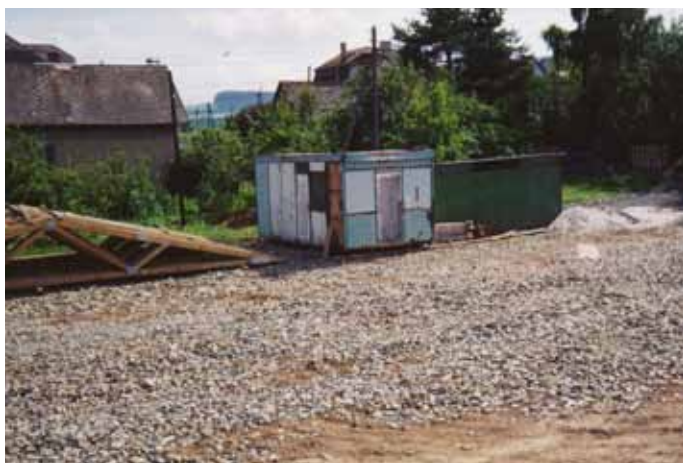
foto č.2 - tak v této buňce v Klenčí začal prodej První chodské, fotka je z roku 1993, kdy se začaly zpevňovat plochy. Jsou vidět i sbíjené vazníky připravené pro první haly v Klenčí
