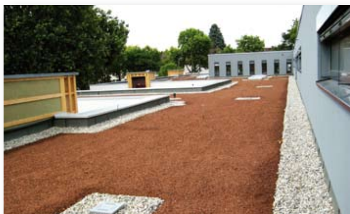
Plošně drenážovaná konstrukce ploché střechy pomocí DELTA-TERRAXX po dokončení.
