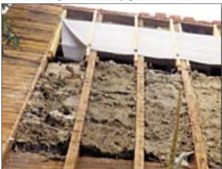
Obr. 5 Oprava střechy po dvaceti letech
