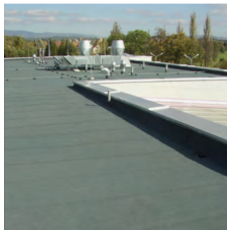
Pohled na plochou střechu s SBS modifikovanými pásy KVK PARABIT
